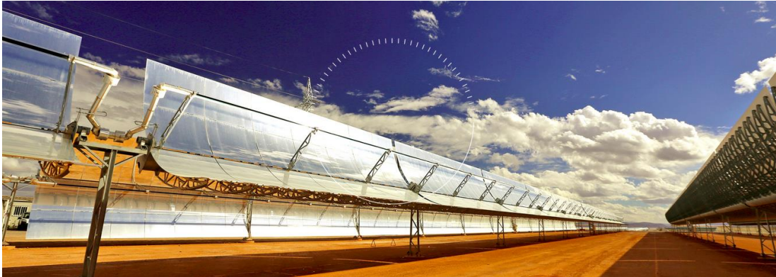
Abbildung 13: Die Parabolspiegel aus dem Solarkraftwerk Noor 1 in Marokko 28
